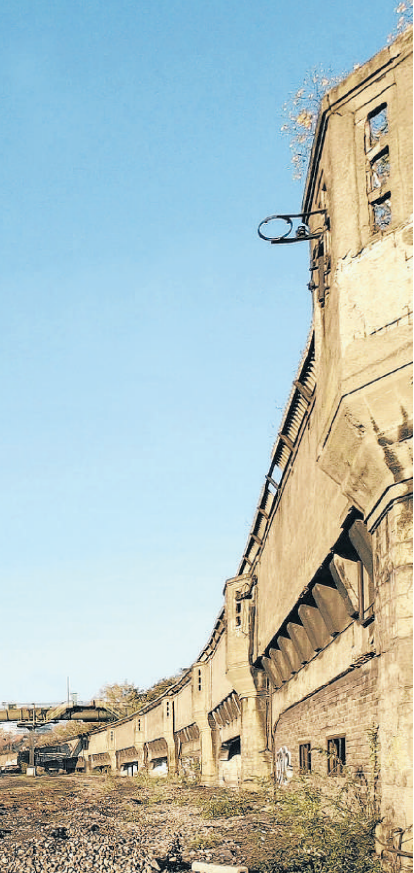
der Industrie in Lofts auf der Brache Phoenix.
